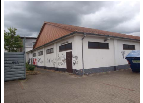
Rückansicht Nahversorger Bornemannplatz ( freiform.architekten )
